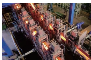
連続铸造設備
