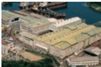
Mitsubishi Nagasaki Machinery Mfg. Co., Ltd.
