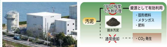
実証実験施設外観 下水汚泥の大幅な減量化と資源化によるゼロ・エミッション化(廃棄物ゼロ)
