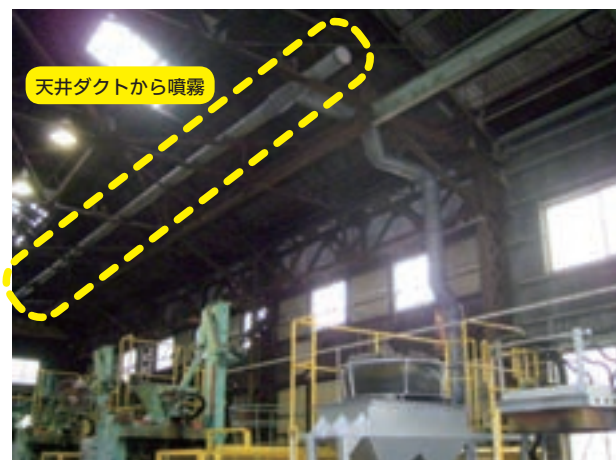
鑄型製作工場のダクトからの消臭
