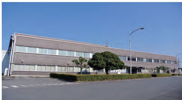
写真1 技術開発センター外観
